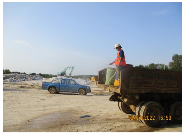
รูปที่ 3-16 ฉีดพรมน้ำเส้นทางขนส่งแร่
