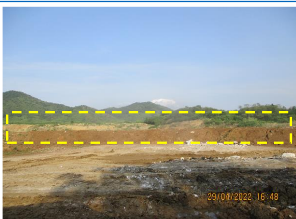
รูปที่ 3-11 คันทำนบดินล้อมรอบพื้นที่เก็บกองเปลือกดิน
